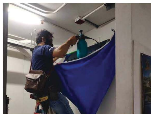
ล้างทำความสะอาดระบบปรับอากาศ
